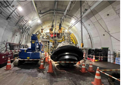
写真③：1次解体状況
