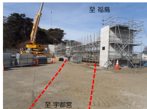
からすがもり ② 鳥ヶ森横断歩道橋の施工状況
