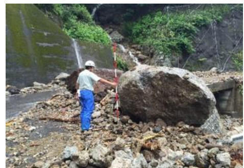
② 落石状況(平成27年9月)
