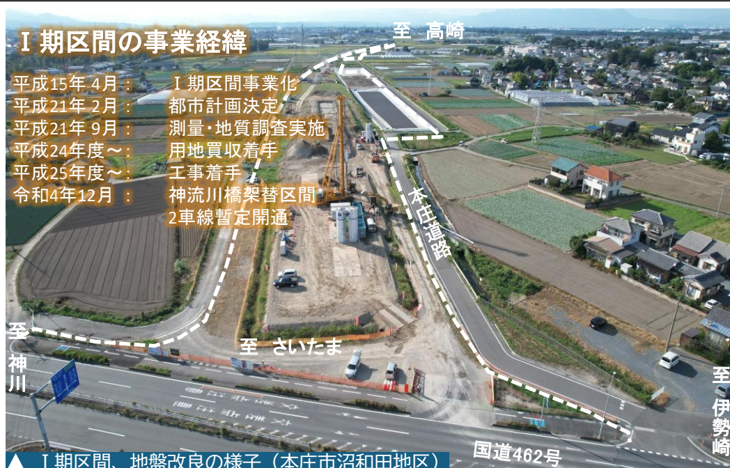
▲Ⅰ期区間、地盤改良の様子(本庄市沼和田地区)
