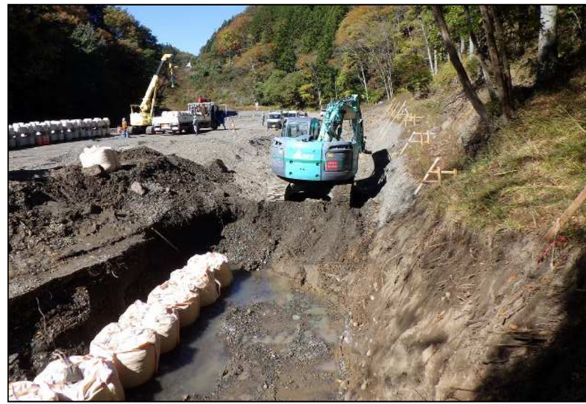
根固工掘削作業中（乙母地区）
