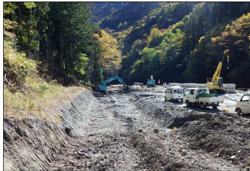
根固工掘削作業中（乙母地区）
