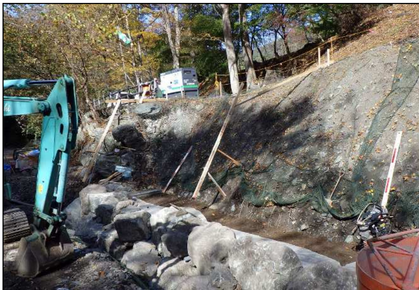
巨石張り施工状況（野栗沢護岸補修）
