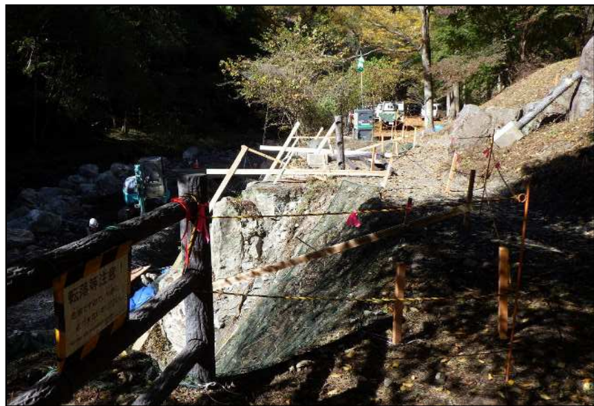
巨石張り施工状況（野栗沢護岸補修）
