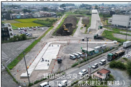
○水路工・貯留槽など
