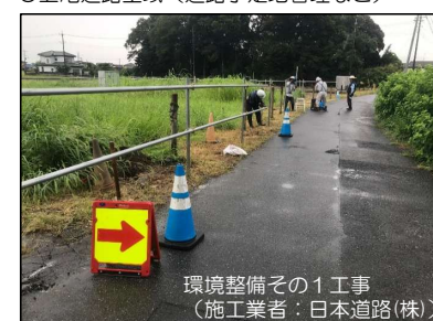
○上尾道路全域（道路予定地管理など）
