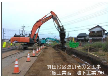
○地盤改良工など
