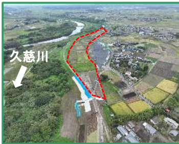
工事箇所の全景(下流から)
