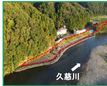
工事箇所の全景(上流から)
