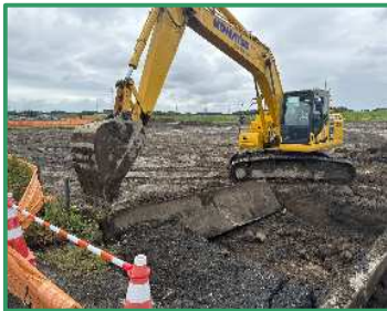
築堤のための準備作業(既設構造物撤去、表土処理)を行っています
