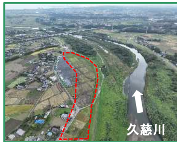
工事箇所の全景(上流から)
