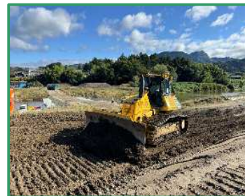
築堤のための盛土作業を行っています
