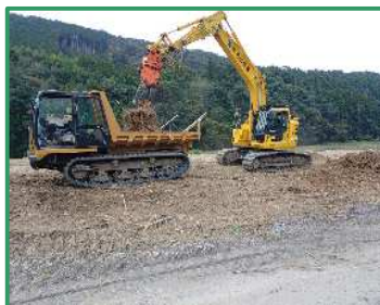
伐採木の積み込み作業を行っています
