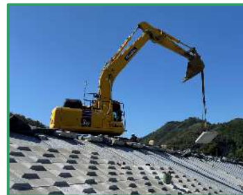
ブロック張り作業を行っています
