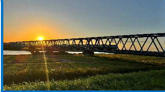
久慈川橋梁(常磐線)堤防から撮影した夕暮れ
