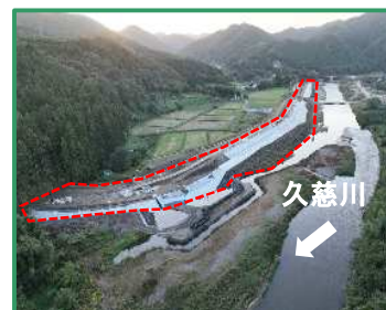
工事箇所の全景(下流から)
