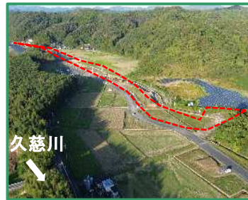
工事箇所の全景(下流から)
