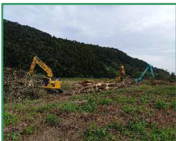
伐採・集積作業を行っています
