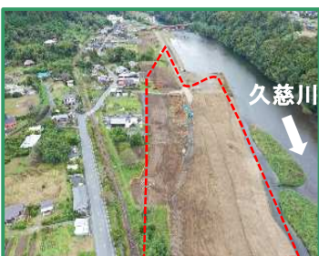
工事箇所の全景(下流から)
