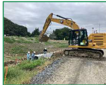
暗渠の布設作業を行っています
