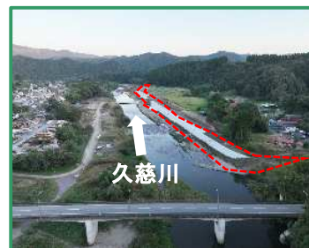
工事箇所の全景(上流から)
