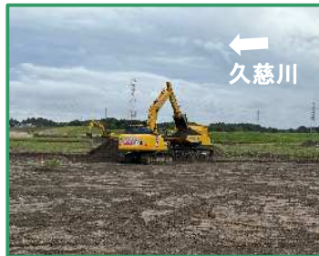
築堤のための準備作業(既設構造物撤去、表土処理)を行っています
