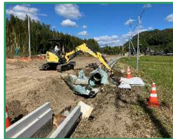
既設水路の撤去作業を行っています
