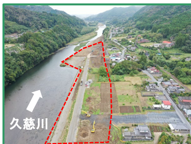
工事箇所の全景(上流から)
