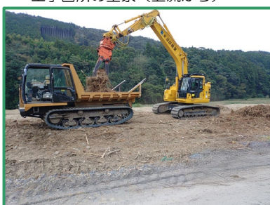
伐採木の積み込み作業を行っています
