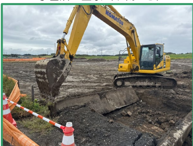
築堤のための準備作業(既設構造物撤去、表土処理)を行っています
