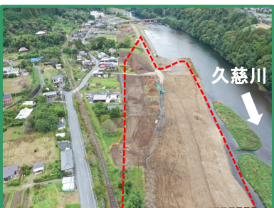
工事箇所の全景(下流から)
