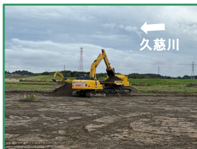
築堤のための準備作業(既設構造物撤去、表土処理)を行っています
