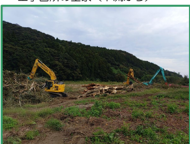
伐採・集積作業を行っています
