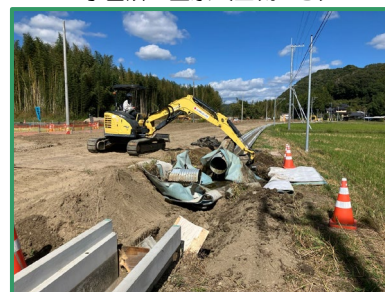
既設水路の撤去作業を行っています
