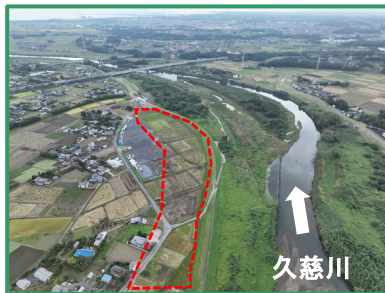
工事箇所の全景(上流から)
