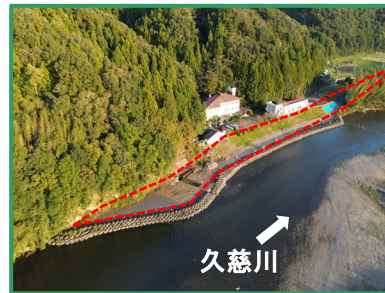
工事箇所の全景(上流から)
