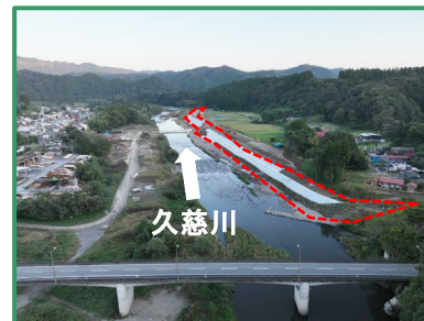
工事箇所の全景(上流から)
