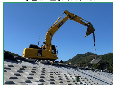
ブロック張り作業を行っています
