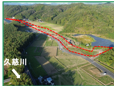
工事箇所の全景(下流から)
