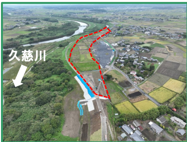
工事箇所の全景(下流から)
