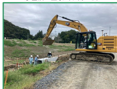
暗渠の布設作業を行っています
