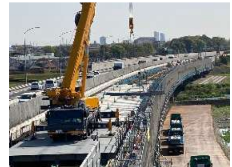
〔中央道多摩川橋 工事状況〕 写真:2025.6
