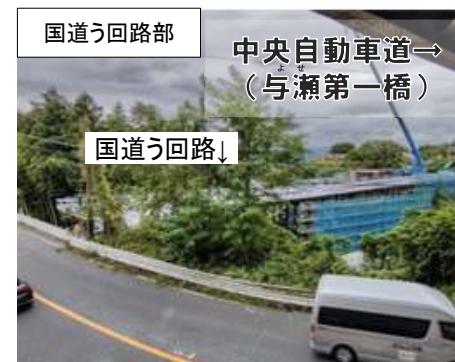
う回路仮橋は2021.3に着手。う回路仮橋の国道接続部の協議が2025.7に概ね完了。
