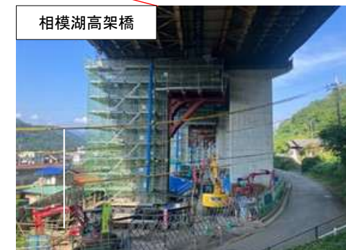
2021.12より下部工の補強工事に着手し、周辺への影響に配慮しながら慎重に施工中。10
