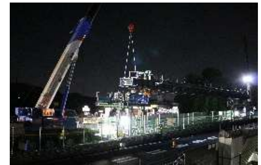
〔稲荷坂橋 工事状況〕 写真:2025.6
