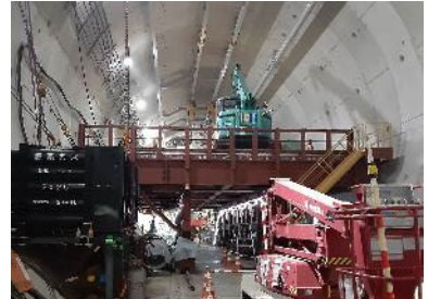
写真②：作業構台等の設置状況
