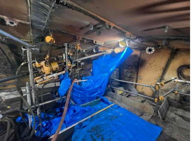
写真④：先受け鋼管の打設状況
