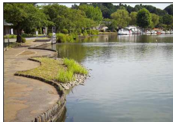
R6.7.25 通水あり
