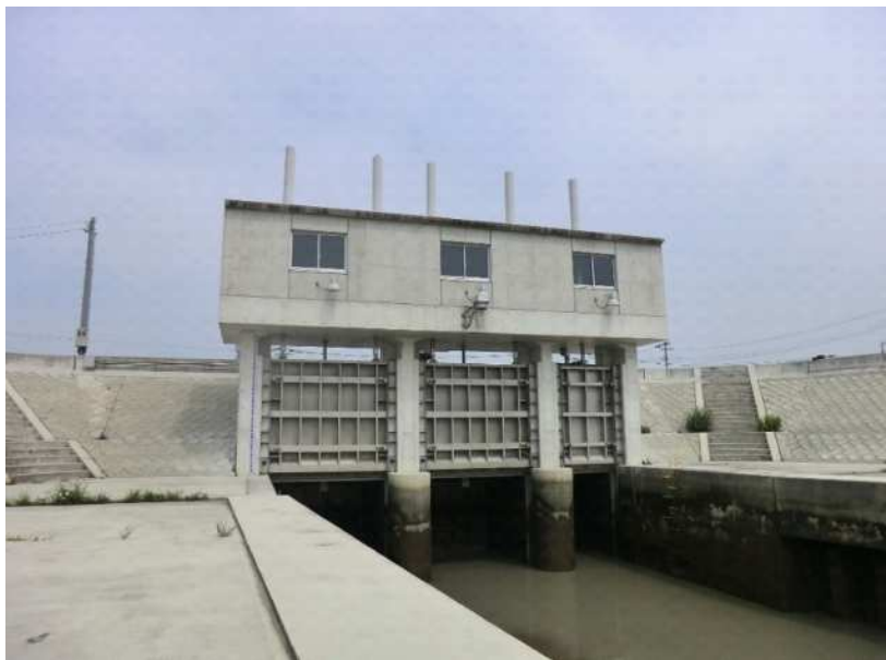
引き上げ式ゲートの例
