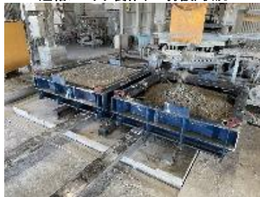
連結ブロック製作(Co打設)状況
