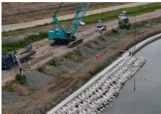
根固めブロック施工状況イメージ
