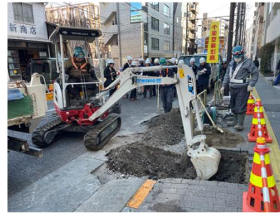
GX建機の実現場での活用事例
