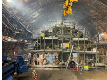
写真⑦：2次解体状況
