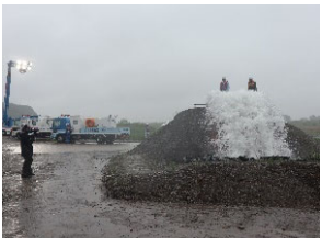
氾濫水排除訓練
