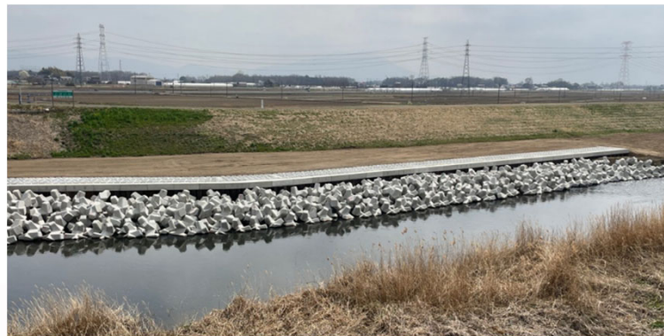
⑤ 小貝川左岸 井出蛭沢地先災害復旧工事
