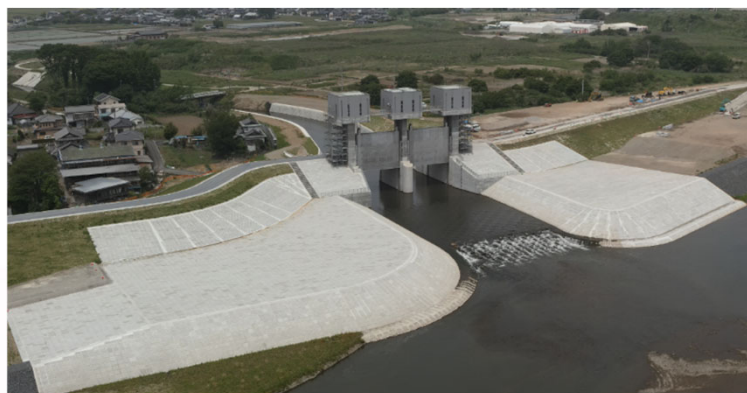
① 田川水門(仮称)新設工事
