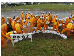
水防団による訓練 (月の輪工)
