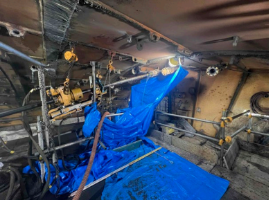
写真④：先受け鋼管の打設状況
