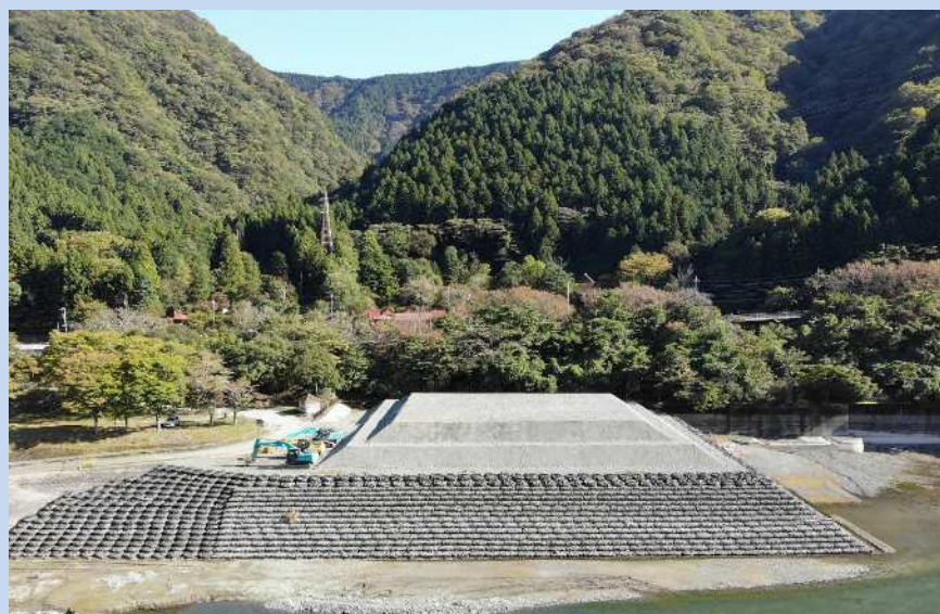
掘削した土砂のストックヤードの状況です。
