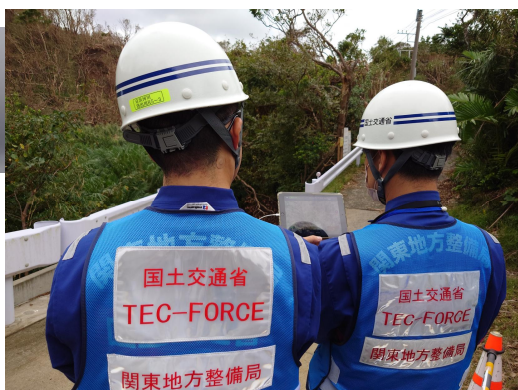
ドローンで上空より被災状況を調査
