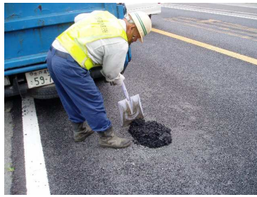
〈ポットホール補修状況〉
