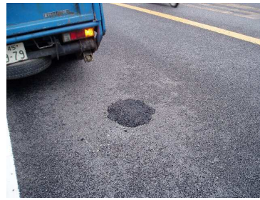
〈ポットホール補修後〉
