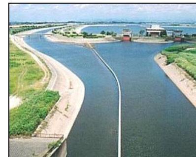
谷田川分離施設
