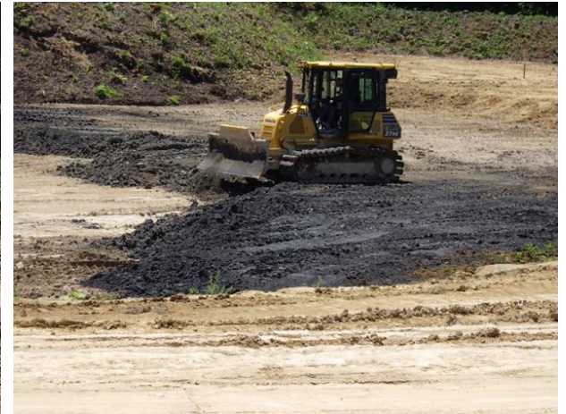
固化処理後の盛土
