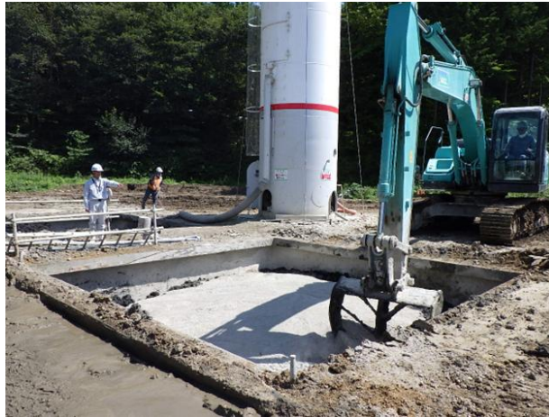
セメントによる固化処理
