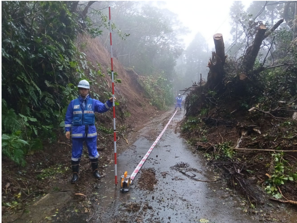
被災状況調査①
