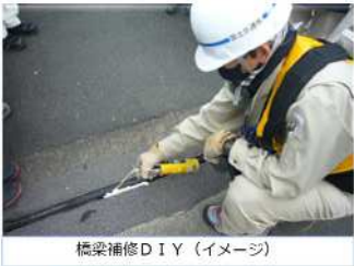
橋梁補修D I Y（イメージ）
