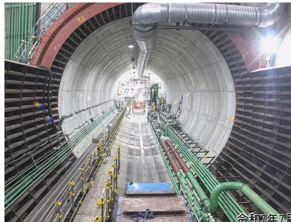
ランプシールド施工状況(中央JCT南側)
