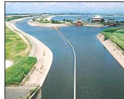
谷田川分離施設
