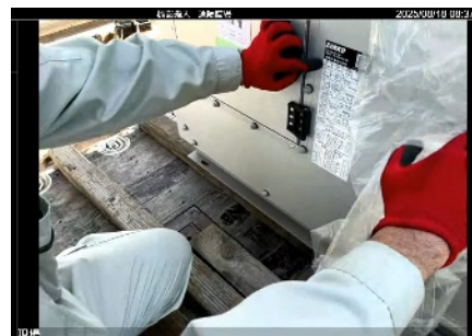
現場での機器搬入状況
