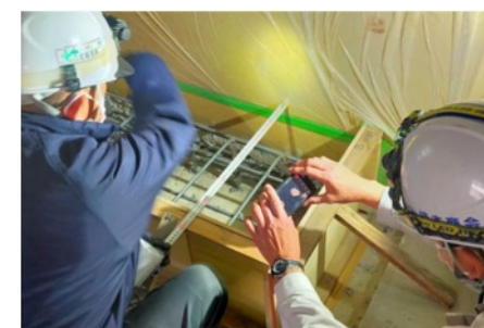
設備基礎配筋検査場面の共有状況
