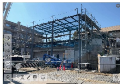
鉄骨建て方実施
