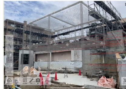
鉄骨建て方各STEP検討・作成
