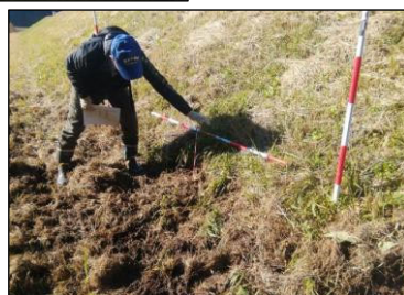
除草後の堤防点検実施状況
