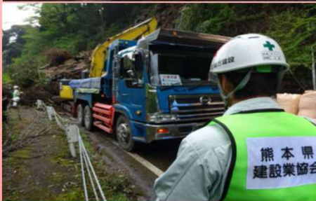
【道路啓開(倒木、崩壊土砂の撤去)】 (県道45号阿蘇講公園菊池線)
