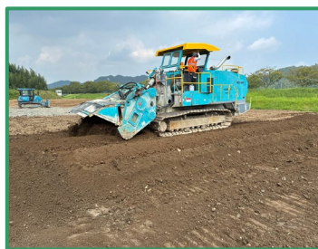
土砂改良を行っています
