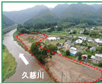
工事箇所の全景(上流から)
