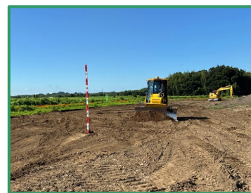
堤防盛土の工事を行っています
