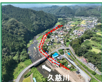
工事箇所の全景(上流から)
