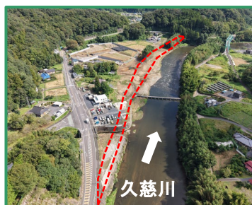
工事箇所の全景(上流から)
