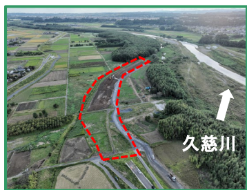
工事箇所の全景（上流から）
