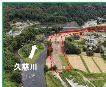
工事箇所の全景(上流から)
