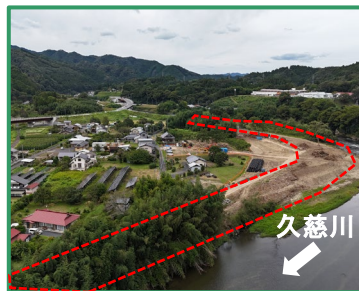
工事箇所の全景(下流から)
