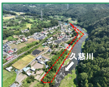
工事箇所の全景(下流から)
