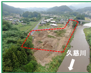
工事箇所の全景(下流から)
