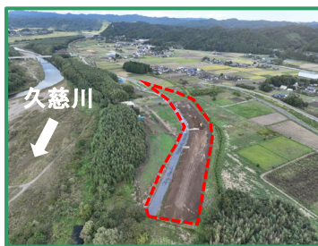
工事箇所の全景（下流から）
