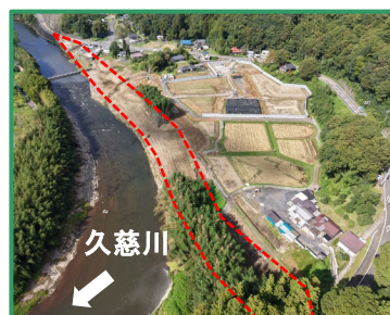
工事箇所の全景(下流から)
