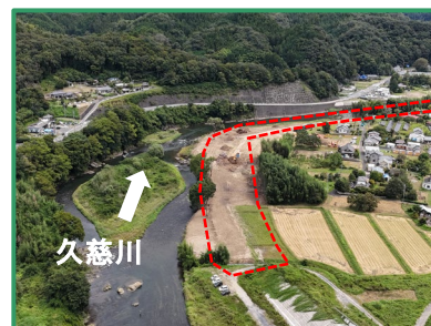
工事箇所の全景（上流から）
