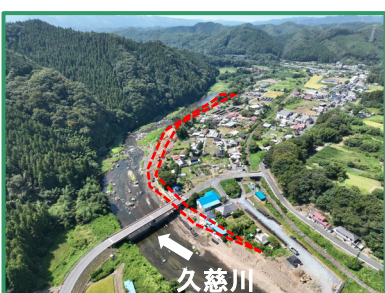
工事箇所の全景（上流から）
