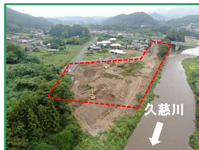
工事箇所の全景（下流から）
