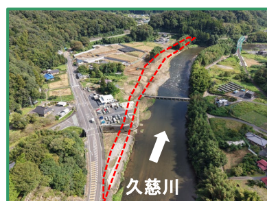
工事箇所の全景（上流から）
