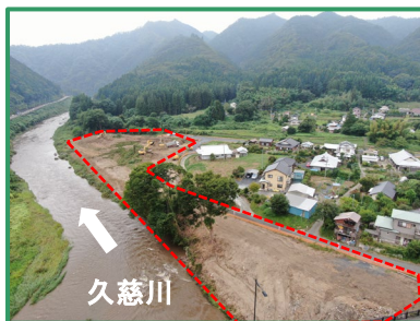
工事箇所の全景（上流から）
