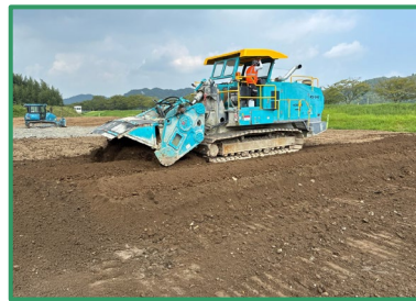
土砂改良を行っています
