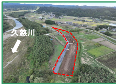
工事箇所の全景（下流から）
