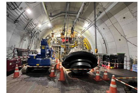
写真③：1次解体状況
