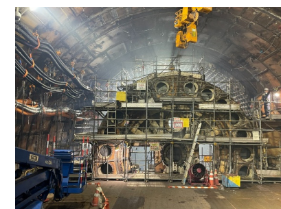
写真⑦：2次解体状況
