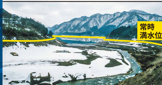
平成9年冬渇水 相俣ダムの様子
