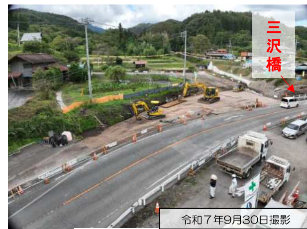
付替道路工 施工状況
