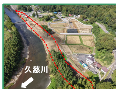
工事箇所の全景（下流から）
