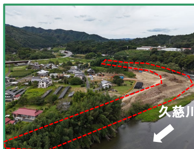
工事箇所の全景（下流から）
