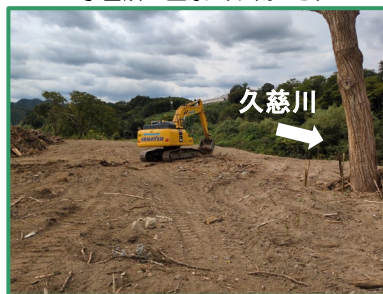
伐採作業を行っています
