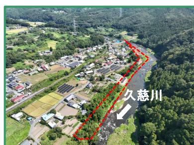
工事箇所の全景（下流から）
