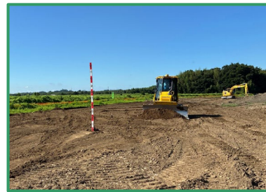
堤防盛土の工事を行っています
