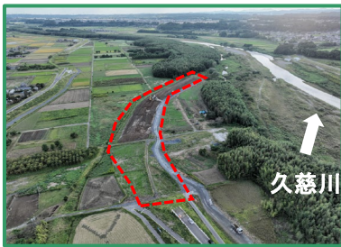
工事箇所の全景（上流から）
