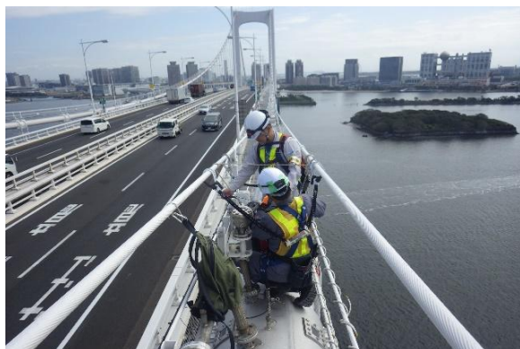
ケーブル送気乾燥システムの調査 (首都高速道路：レインボーブリッジ)
