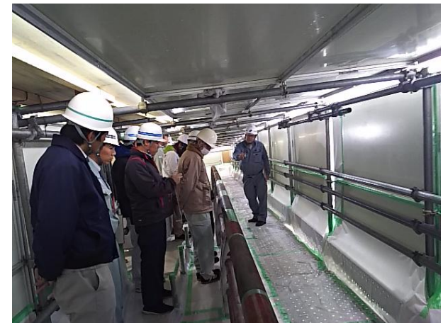
（橋梁修繕工事現場見学会） ※イメージ
