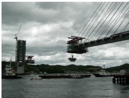
設計施工アドバイス（愛媛県：生名橋）
