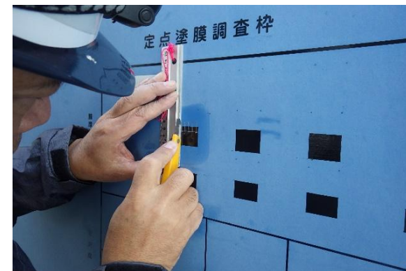
定点塗膜調査 (島根県：浜田マリン大橋)
