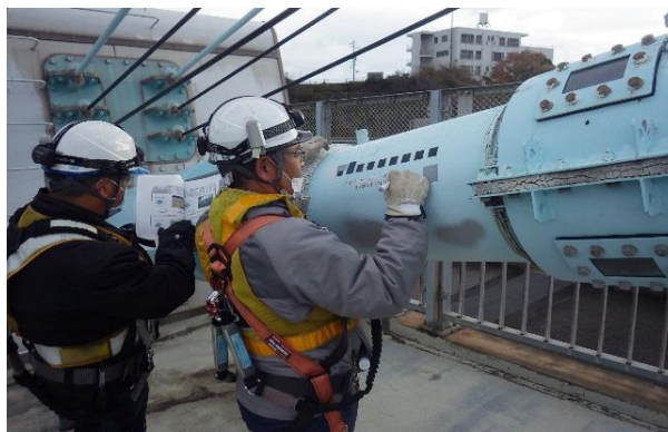
塗膜の健全性調査 (広島県：安芸灘大橋)
