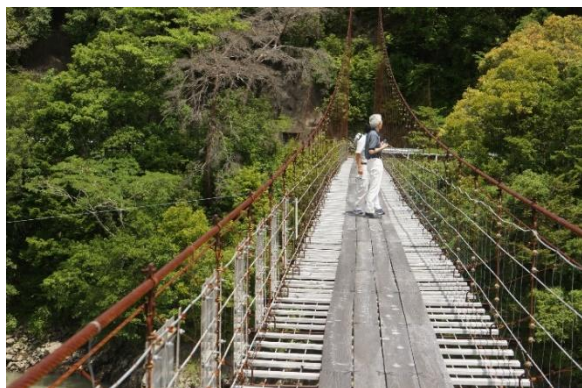
技術協力協定による調査 (奈良県十津川村：吊橋群)
