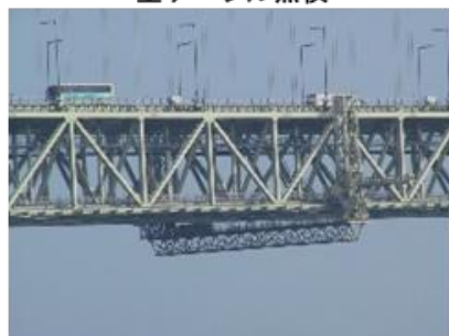
桁外面作業車
