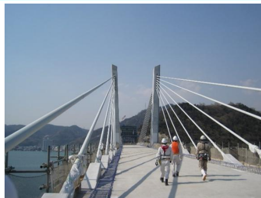
CM業務（岡山県備前市：日生大橋）
