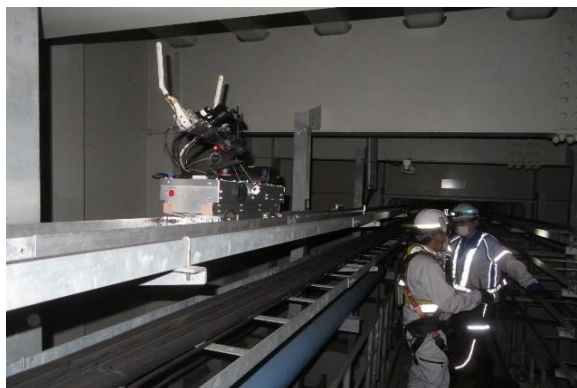
鋼床版疲労き裂調査手法の検討 (東京湾横断道路：東京湾アクアブリッジ)
