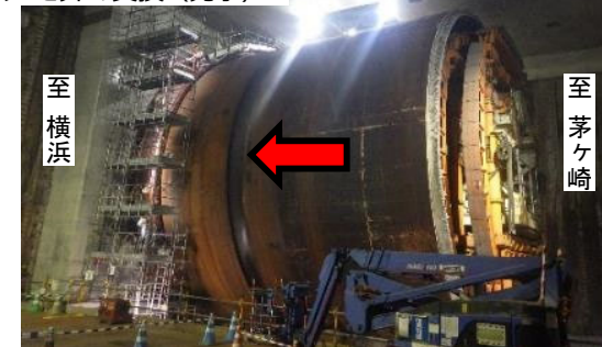
写真①：シールドマシンの前移動
