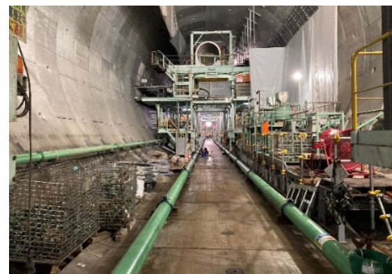
写真⑤：土砂圧送配管敷設状況
