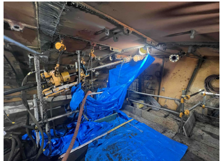
写真④：先受け鋼管の打設状況
