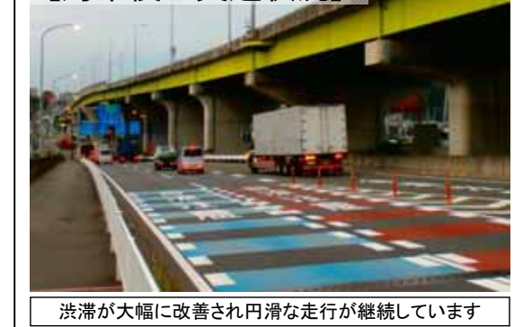
【対策後の交通状況】
