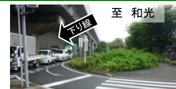
写真A: 植栽により左折時に横断歩道が見づらい
