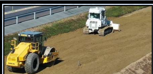
MCブルドーザによる敷均し GNSSを用いた盛土の締固め管理
