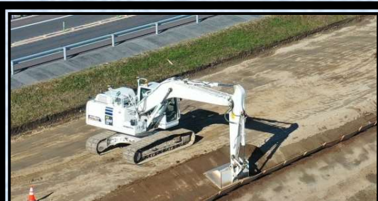
MCバックホウによる法面整形
