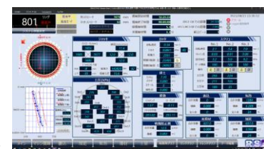
掘進管理システム
