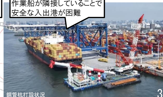
鋼管杭打設状況
