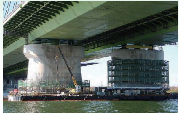
▲幸魂大橋耐震補強工事
