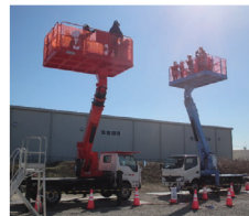
高所作業車試験体験
