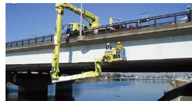
橋梁点検車による点検
