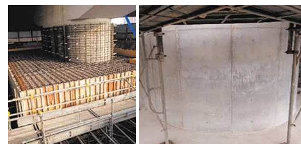
潮郷橋耐震補強工事(橋脚補強)
