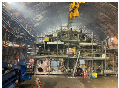
写真⑦：2次解体状況
