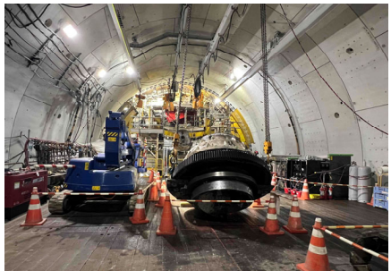
写真③：1次解体状況
