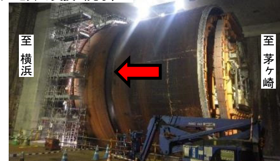
写真①：シールドマシンの前移動
