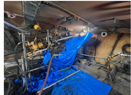
写真④：先受け鋼管の打設状況
