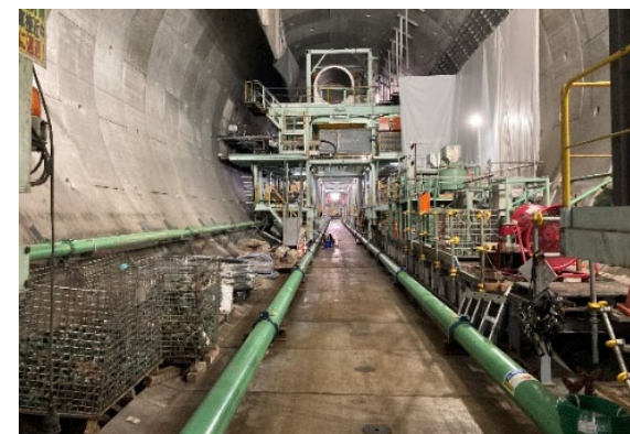
写真⑤：土砂圧送配管敷設状況
