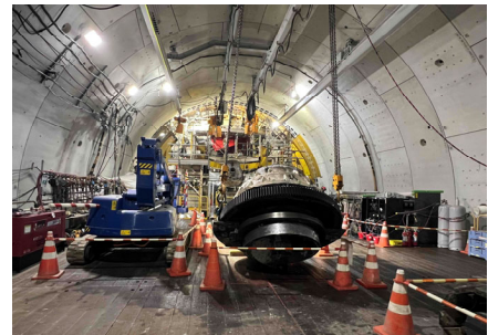
写真③：1次解体状況
