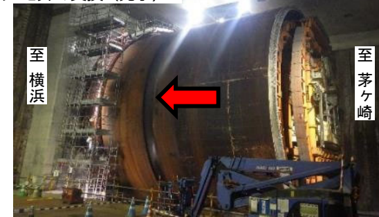
写真①：シールドマシンの前移動
