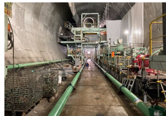
写真⑤：土砂圧送配管敷設状況
