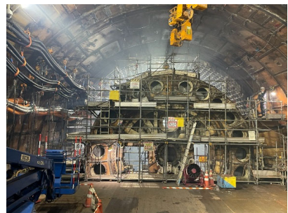
写真⑦：2次解体状況
