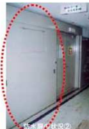
防水扉の状況②
