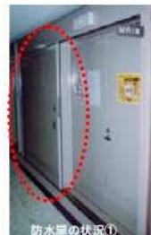
防水扉の状況①
