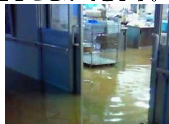
特別養護老人ホーム 幸福園の浸水状況 （出典：山口県 福祉施設等の災害対策取組事例集）
