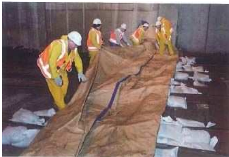
ハリケーン・サンディでの地下鉄会社の浸水防止の取組
