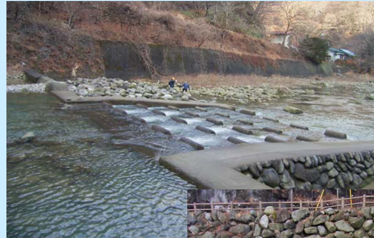
坂本沢上流床止め1.0
