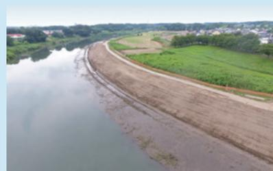
**漏水対策** 平成27年9月洪水で漏水箇所の対策を行うとともに、漏水の危険性が高い箇所の対策を行いました。
