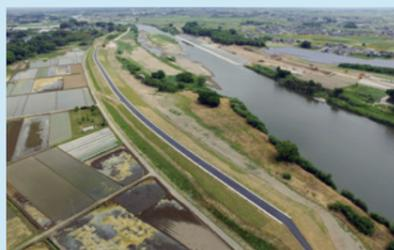
**河道掘削** 平成27年9月洪水と同規模の洪水を計画高水位以下で流せるよう、河道の掘削や河道の拡幅を行いました。
