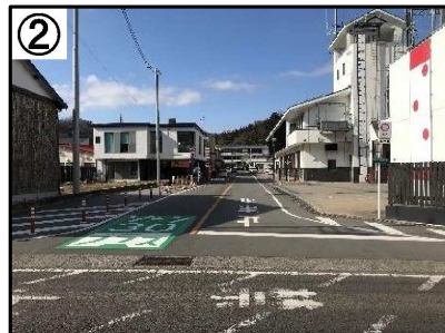
ゾーン30プラス看板・路面標示
