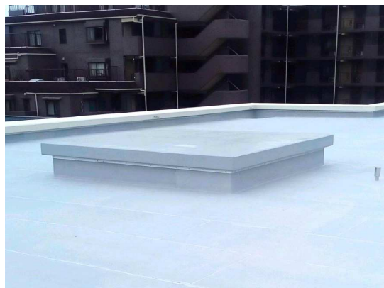
屋上防水改修
