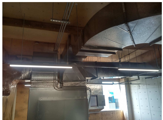
機械室換気設備改修
