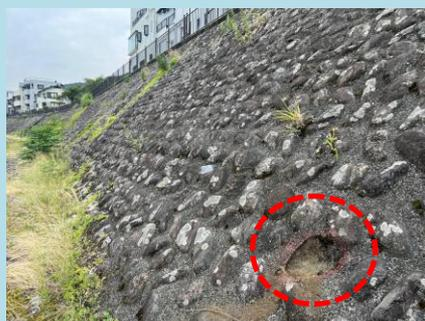
堤防・護岸の点検状況(抜け石)
