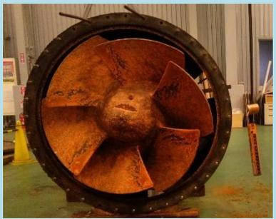
機械設備、電気通信設備等の機器更新状況(ポンプ羽根車の更新)
